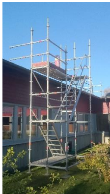
Figur 13. Trapptorn som tillträde till tak
