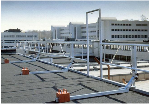
Figur 22a Motviktsystem Zip-Up. Observera för låg fotlist.
